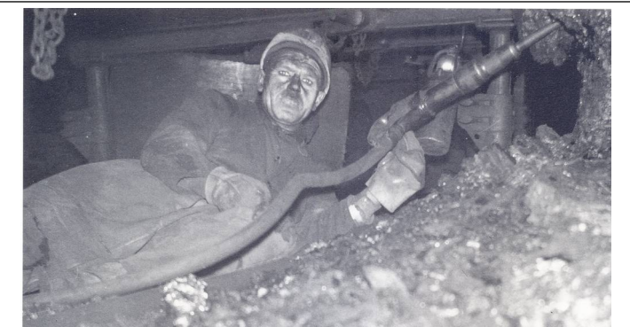
Hauer Jonat Martin aus Lindhorst vor Ort, Abbau der Kohle mit Preßlufthammer
