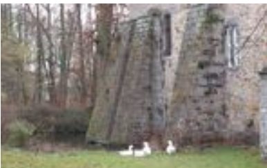
← Mächtige Pfeilervorlagen zur Entlastung der Fundamente
