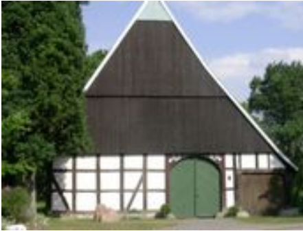
Die im 17. Jh. errichtete Fachwerkscheune am Eingang wird ebenfalls eigenhändig von den Besitzern restauriert.
