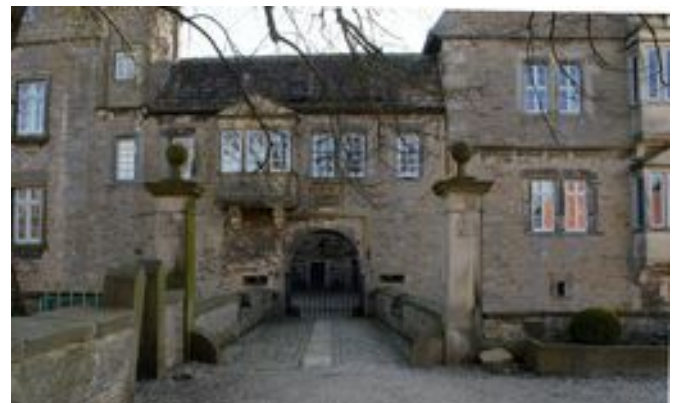
Zugang zum Schloss Innenhof
