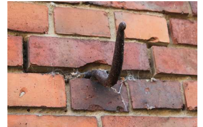
Fleischerhaken an der Rückseite der Scheune.
