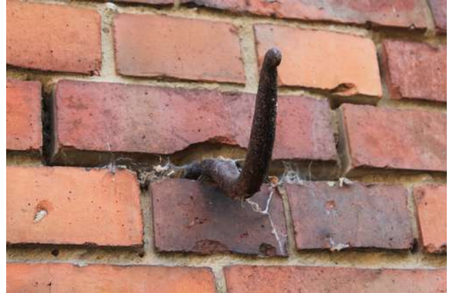
Fleischerhaken an der Rückseite der Scheune.
