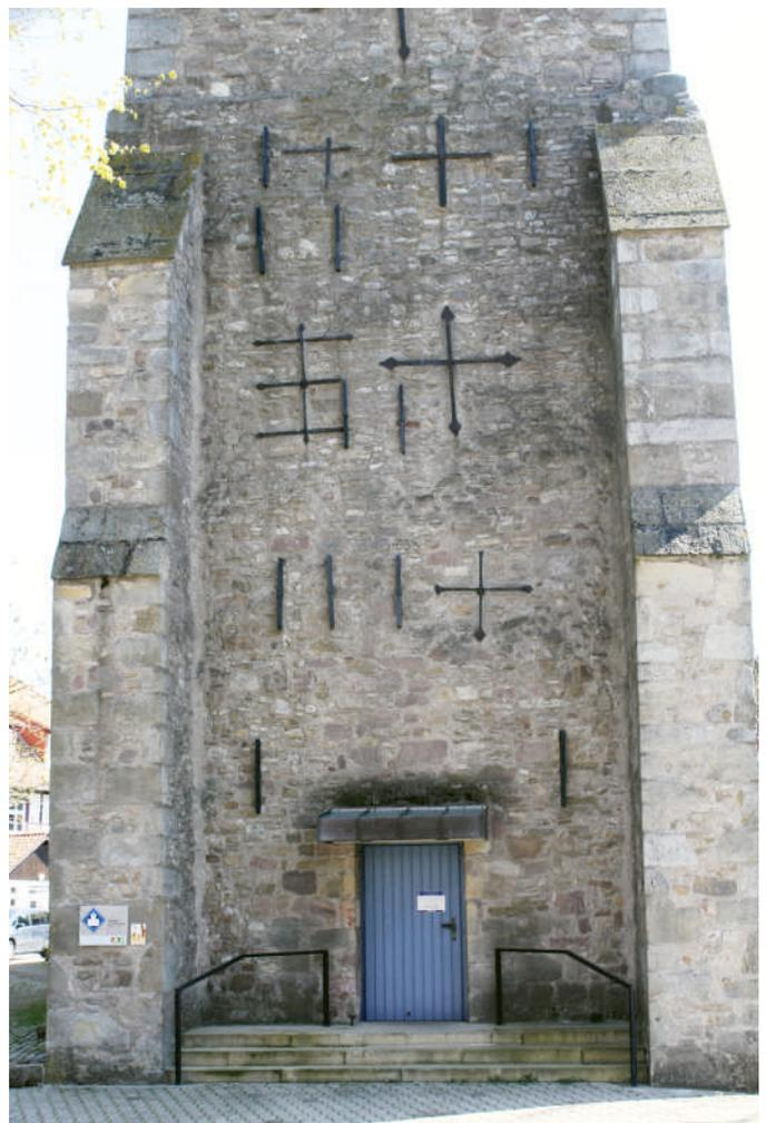
Abb. 7: Eisernen Anker stabilisieren den Kirchturm in Fuhlen
