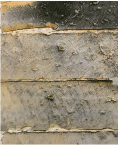
Abb. 8: Das mittige Loch in den Quadersteinen verweist auf eine alte Krantechnik
