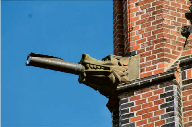
*Abb. 18: Neugotischer Wasserspeier am Turm*
